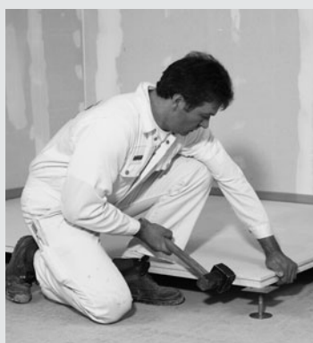
Łączenie elementów podniesionej podłogi
